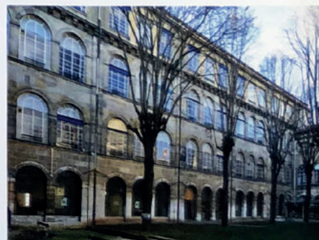
Le bâtiment avant travaux.
