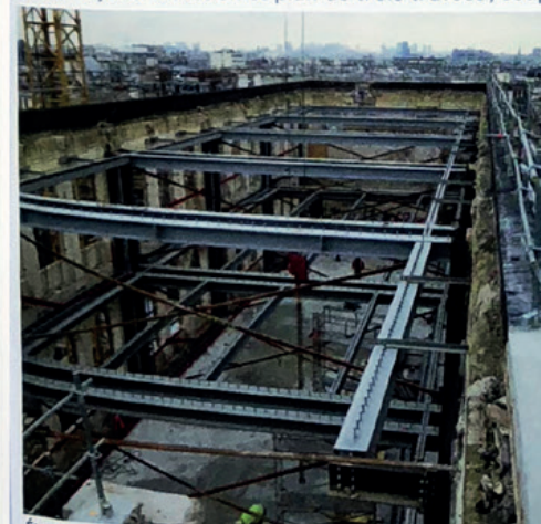
Étaye des façades et pose des nouveaux planchers.
